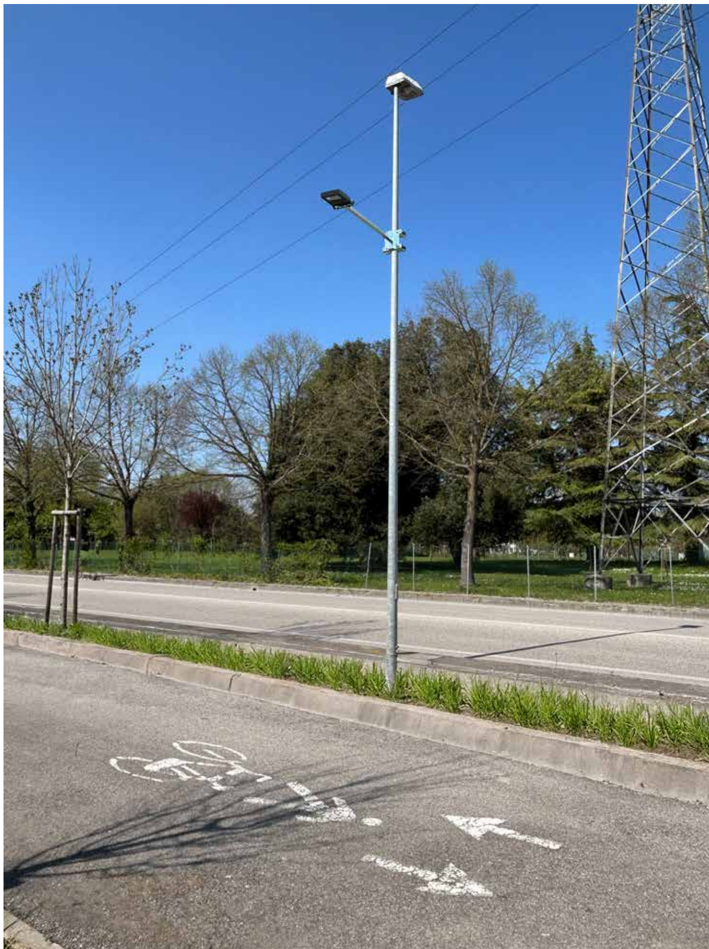
Sbraccio L 1000 mm AS1014FZ p. 181 con ganasce per fissaggio al palo AS3000FZ p.182 + staffa inclinata a 45°ADX303FZ p. 184 per fissaggio proiettore
