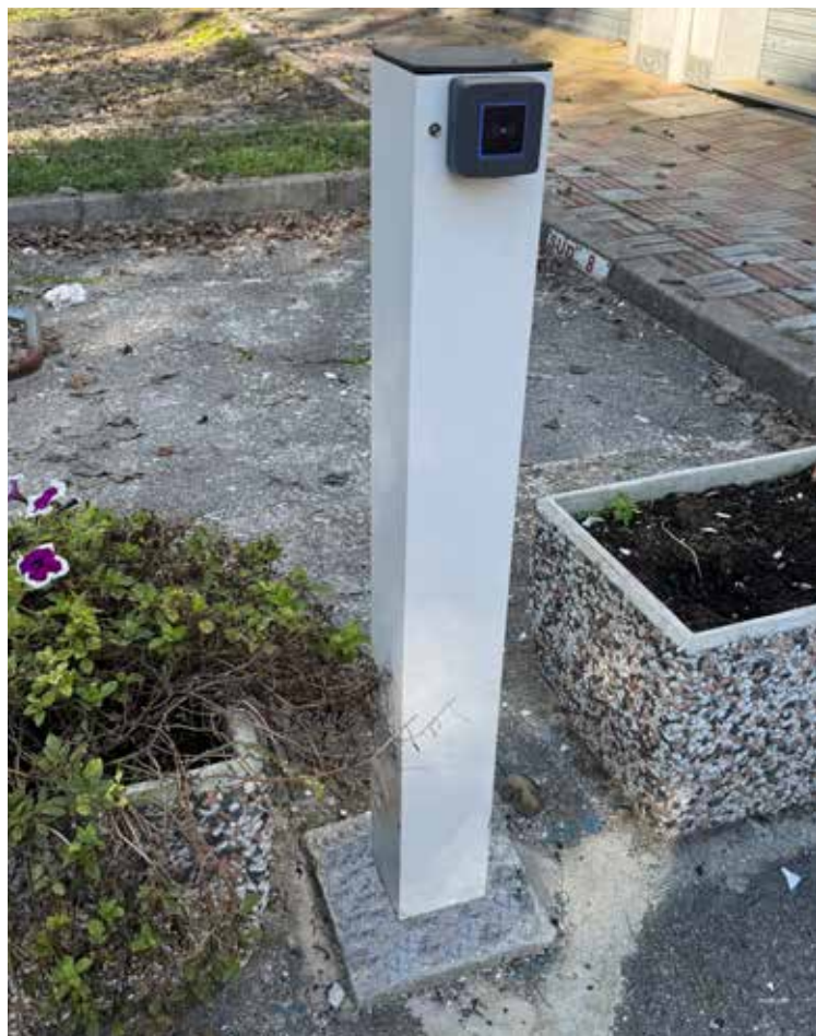
Palo Boston100 H 1500 mm bianco - incastrato: incassato in fondazione di calcestruzzo
