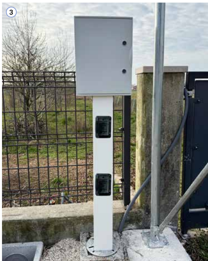
Palo Boston120 H 1000 mm bianco - installazione a pavimento con base CQBL25FZ + staffe di supporto testa palo CQA052FZ + 2 fori 3 moduli CRF003FN
