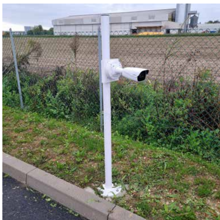
Staffa universale per telecamere AM2957FB p. 203 + palo Boston60 H 1500 mm - installazione a pavimento e a soffitto con base PF0060FB + tappo ABS AP0260PN
